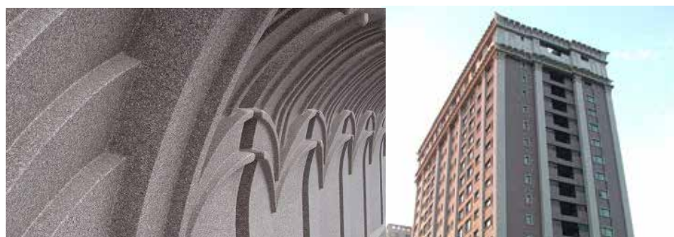
於樓頂異型部分，使用GRC噴塗釉彩花崗石塗料，搭配基作石材花色作一使用，以降低整體建築物之負載壓
