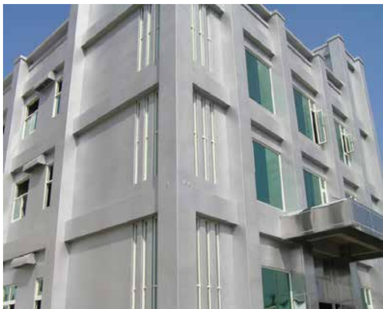
奈米仿金屬塗料，RC牆面塗裝成金屬質感。
